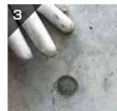
ひび割れに材料が入り込む様、少し盛り気味に塗りつける
