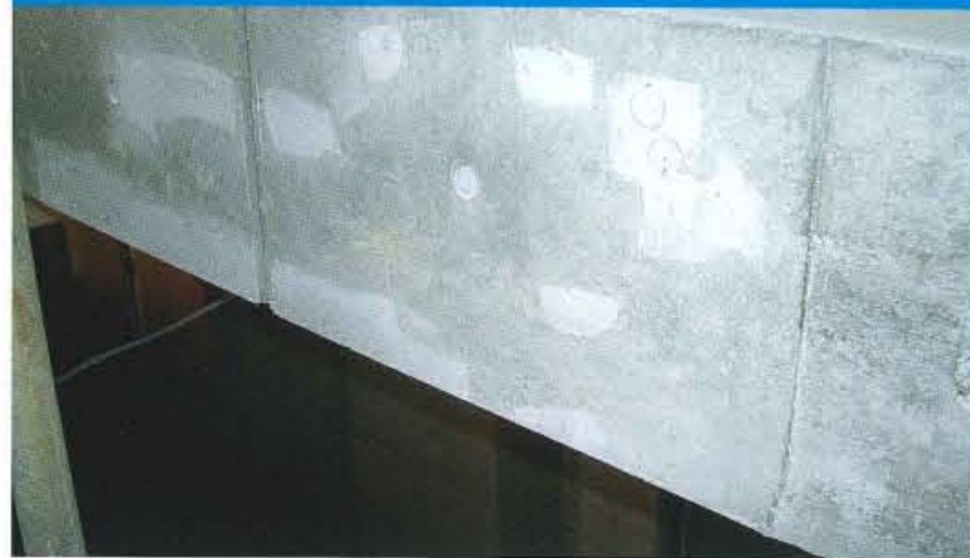
下地処理状況 (パテ跡)
